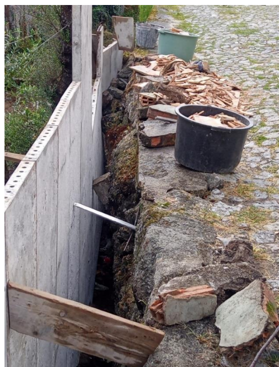
Reforço de muro de suporte da estrada na Rua Ribeiro Gonçalves
